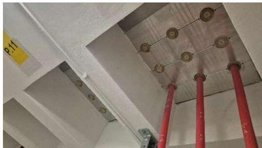
33. GPZ Gorzyce – poziom -1 (kablownia)
