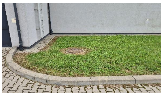
48. Teren stacji GPZ
