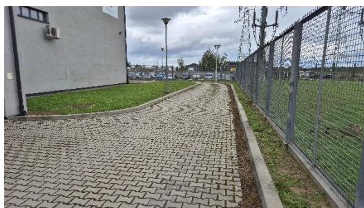
46. Teren stacji GPZ
