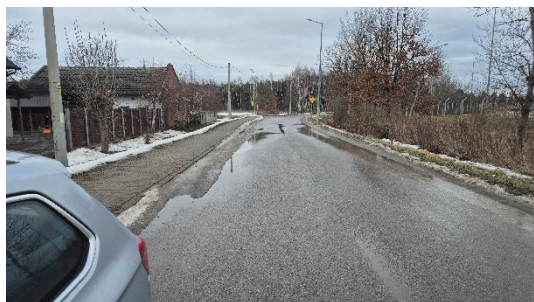
11. Droga dojazdowa – direction NE
