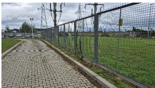
47. Teren stacji GPZ
